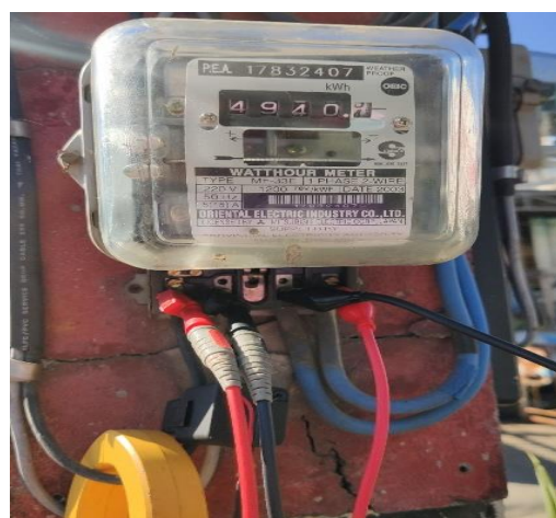
รูปที่ 6 การคีบสายเพื่อวัดค่าทางไฟฟ้า
