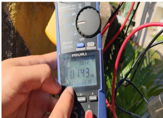
รูปที่ 7 วัดค่าทางไฟฟ้าจากมัลติมิเตอร์
