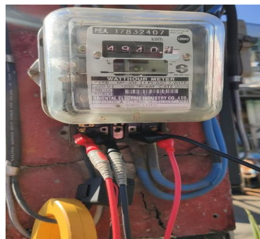
รูปที่ 6 การคีบสายเพื่อวัดค่าทางไฟฟ้า
