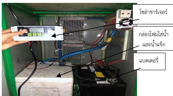
รูปที่ 8 การต่อสายไฟเข้ากับระบบแผงโซลาร์เซลล์
