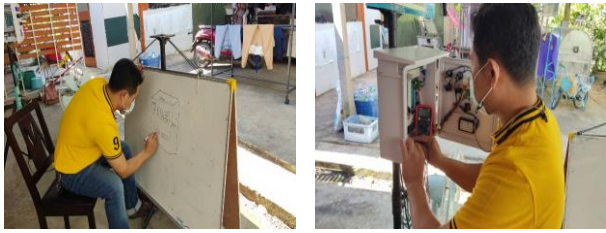
รูปที่ 2 การออกแบบและสร้างตู้ระบบควบคุมการวัดค่าอุปกรณ์ไฟฟ้าด้วยเทคโนโลยี IoT
