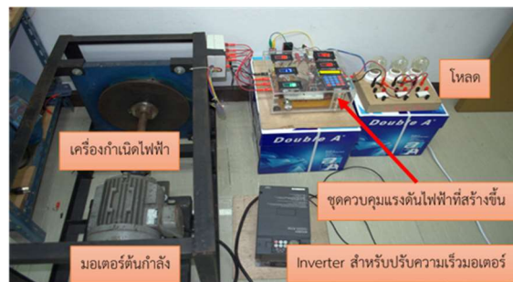
รูปที่ 8 การทดสอบชุดควบคุมแรงดันไฟฟ้า
